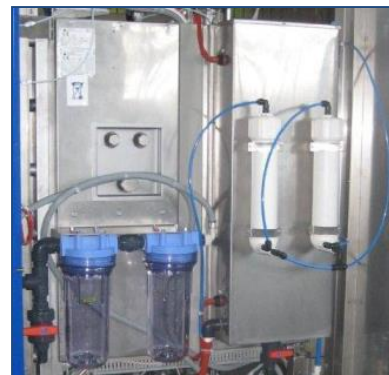
Sistema Incorporado de Osmose Inversa
